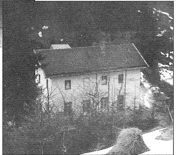
Das ehemalige Gemeinde - E-Werk vom Sendersweg gesehen
