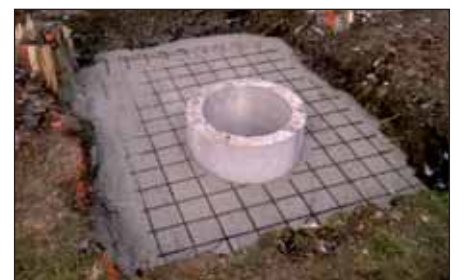
Fundament Fluchtlichtmasten
