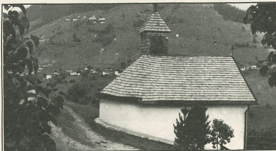
Die Tafel Kapelle in Grinzens im Ortsteil Brandegg. Auf der schmalen, steilen Straße von hier hinunter ins Sellrain waren die Schäden durch die Mure auszubessern und man ist dabei mit bemerkenswertem Gespür für die natürlichen Gegebenheiten vorgegangen.
