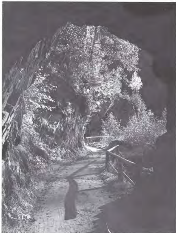
Die wildromantische Eingangsschlucht bot für den Straßenausbau die größten Hindernisse. Auf dem Bild der alte Zillergrundweg beim Tunnel.
