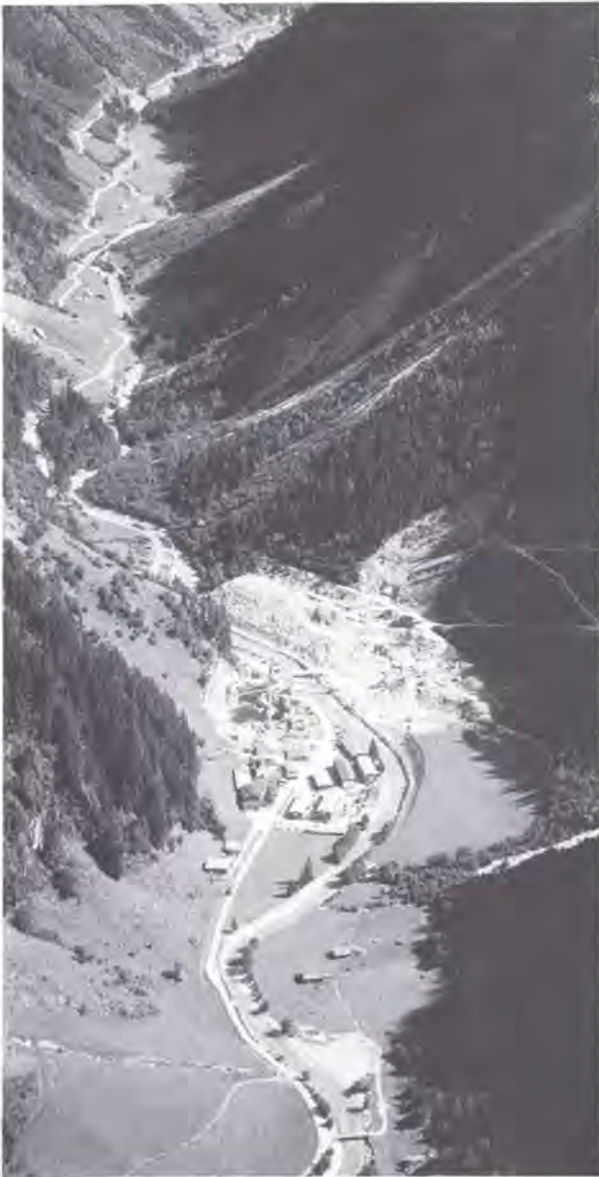
Hinter der Kirche Maria Schnee in Häusling entsteht das riesige Krafthaus. Neben der Kraftwerksstraße wird künftig die mächtige Hochspannungsleitung die Wanderer nach Mayrhofen begleiten.
