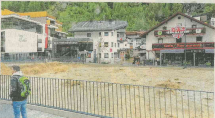
In Sölden waren die Brücken für längere Zeit unpassierbar und gesperrt. Bewohner und Gäste wurden gebeten, nicht ins Freie zu gehen.
