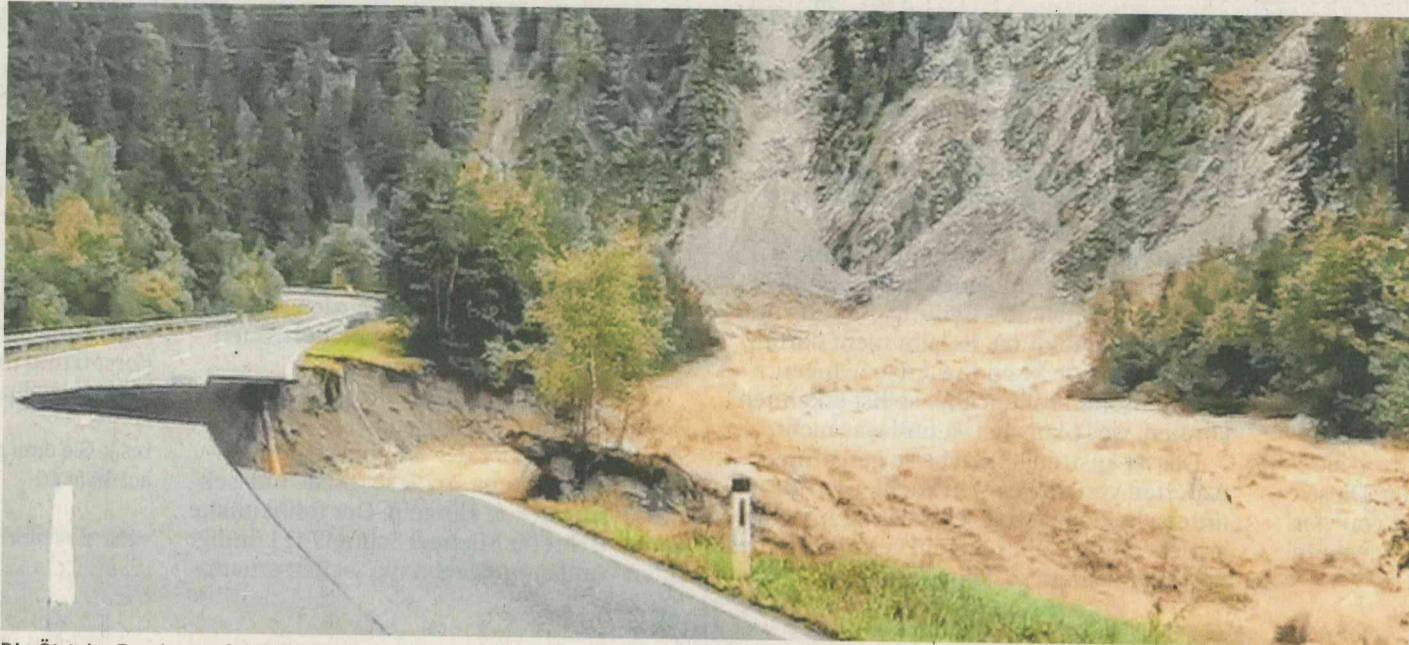
Die Ötztaler Bundesstraße B186 wurde zwischen Umhausen und Längenfeld nahe der Abzweigung Köfels teilweise weggerissen.
