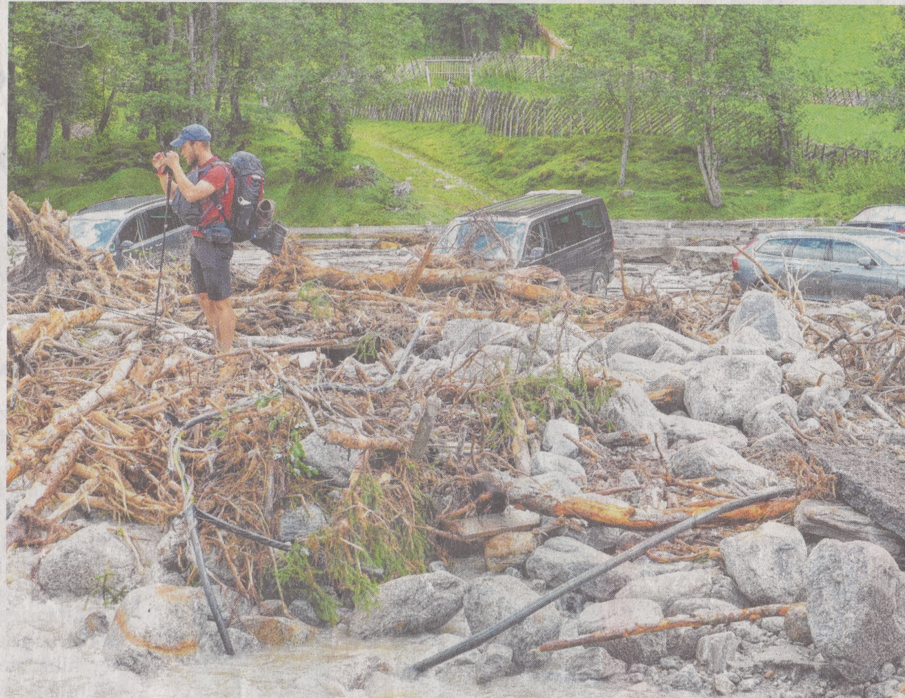
Im Valsertal riss eine riesige Mure Autos mit und zerstörte eine Brücke.
