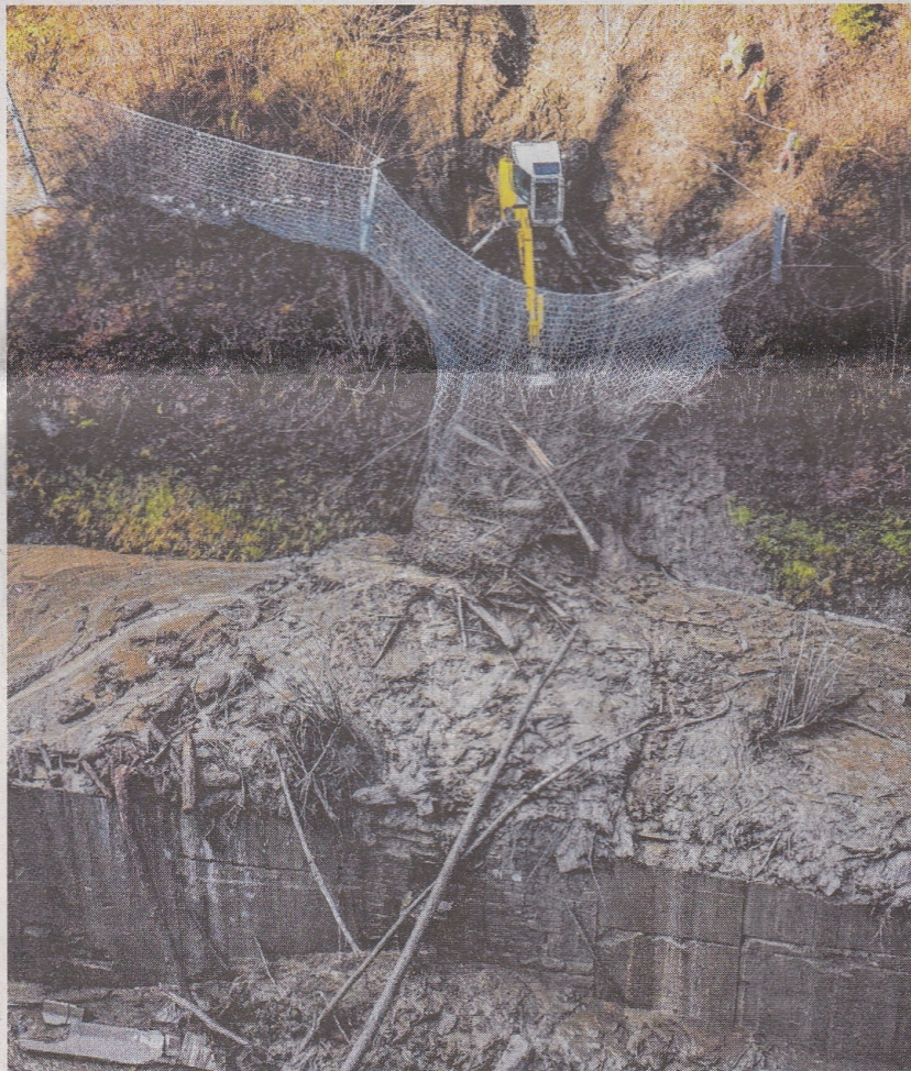
Nicht nur in Tirol verlegten Muren Straßen oder beschädigten Häuser. Auch in Kärnten oder Salzburg (im Bild eine Schlammlawine zwischen Lend und Schwarzach) waren die Schäden beträchtlich.
