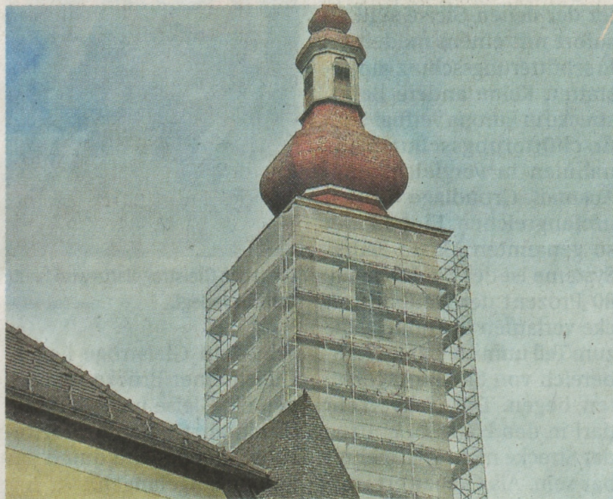
Bis Ende September dauern die Sanierungsarbeiten am Kirchturm von St. Margarethen in der Gemeinde Buch.
