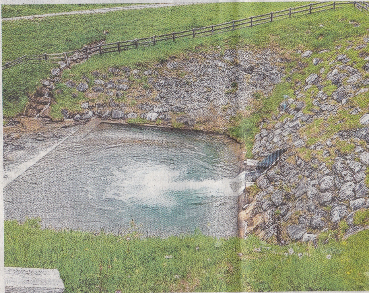
Retentionsbecken am Berg – wie hier in Gerlos – sind für die Bauern ein Muss beim Hochwasserschutz. Foto: Weratschnig
