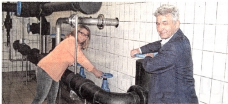
BM Marion Wex und BM Dietmar Wallner drehen gestern die Leitungen auf, damit das Trinkwasser nach Buch fließen kann.
