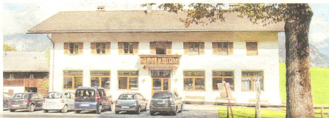
Eine Klasse musste im oberen Stockwerk untergebracht werden. Ein Neu- oder Umbau der VS Gallzein ist unumgänglich.
