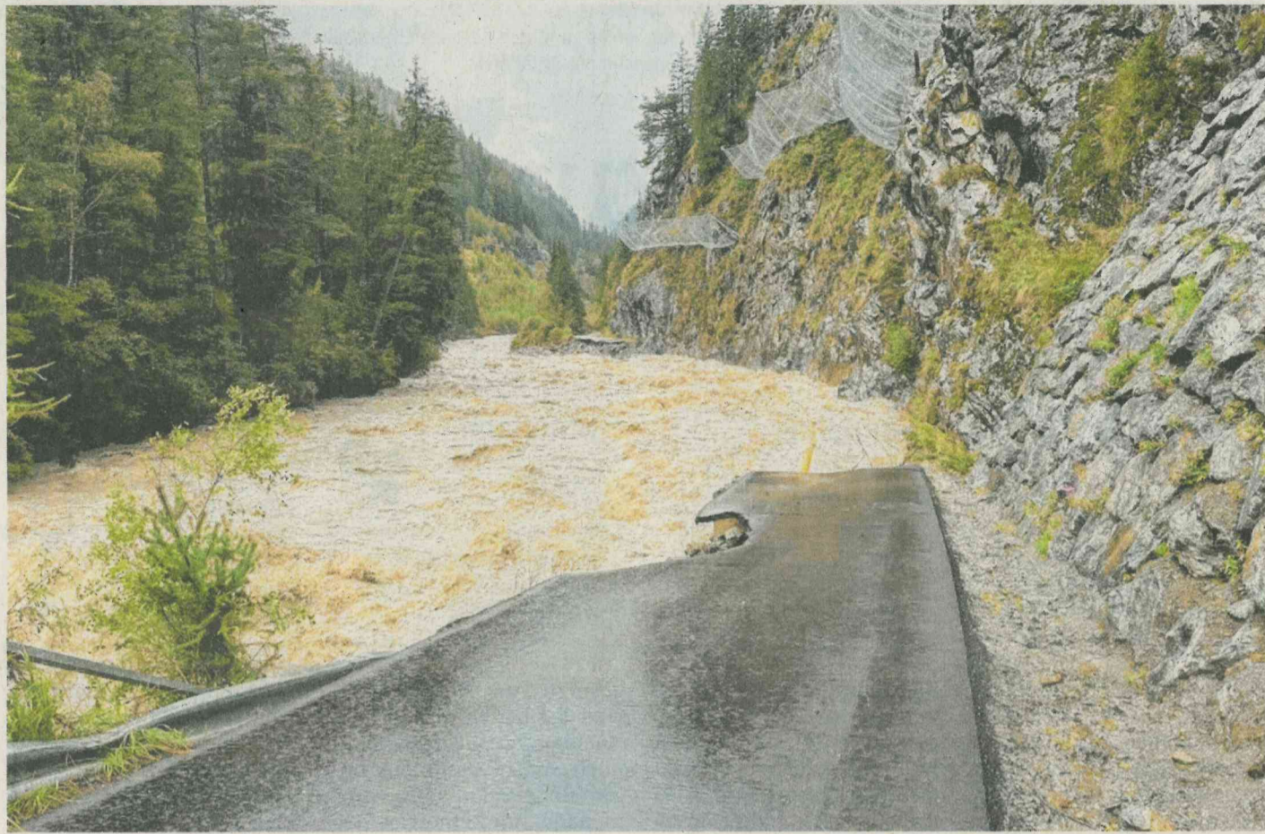
Schwere Schäden im Ötztal: Gleich mehrere Straßen wurden von den Wassermassen mitgerissen.
