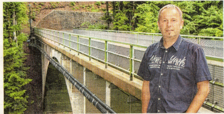
Bürgermeister Josef Brunner sieht die Generalsanierung der 1957 errichteten Bucherbachbrücke als Notwendigkeit. Foto: Dietmar Walpoth
