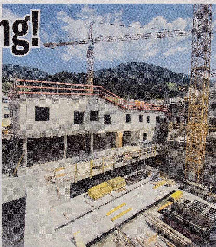
Die Bauarbeiten für das „Quartier am Raiffeisenplatz“ in Schwaz sind im Zeitplan: Die Fertigstellung ist für September 2022 geplant.
