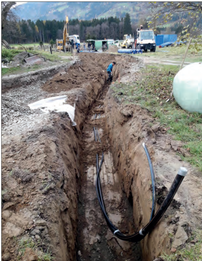
Mit den Straßenbauarbeiten wurden LWL, Abwasserkanal, Straßenbeleuchtung und Nutzwasserleitung mitverlegt.
