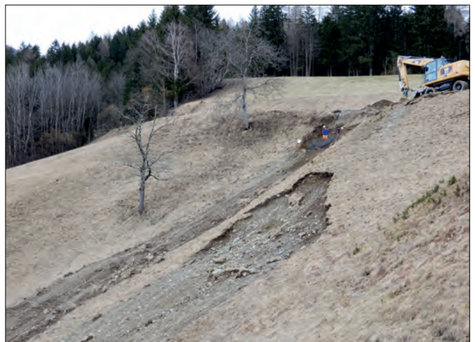
Rutschungen und Straßenabsetzungen.
