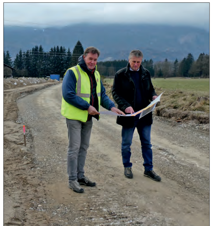
Bürgermeister Josef Mair und der Leiter der Agrar Lienz DI Hubert Mühlmann machen sich ein Bild vom Fortschritt der Bauarbeiten.
