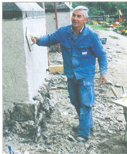
Albert Kuntner, wie schon so oft bei unentgeltlicher Maurerarbeit: hier beim Sockelverputzen der Südfassade.
