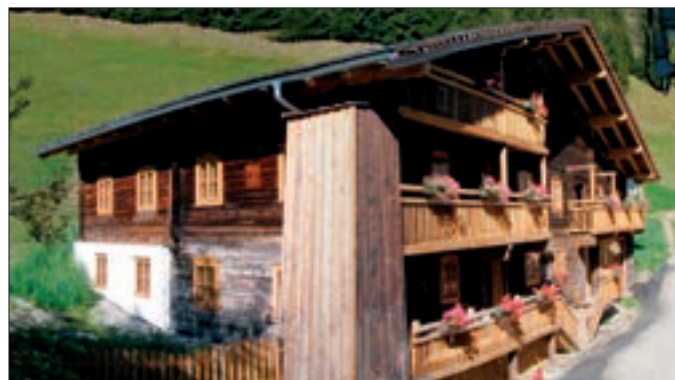
St. Jakob i. D.: Sanierung Bauernhaus Trogach.
