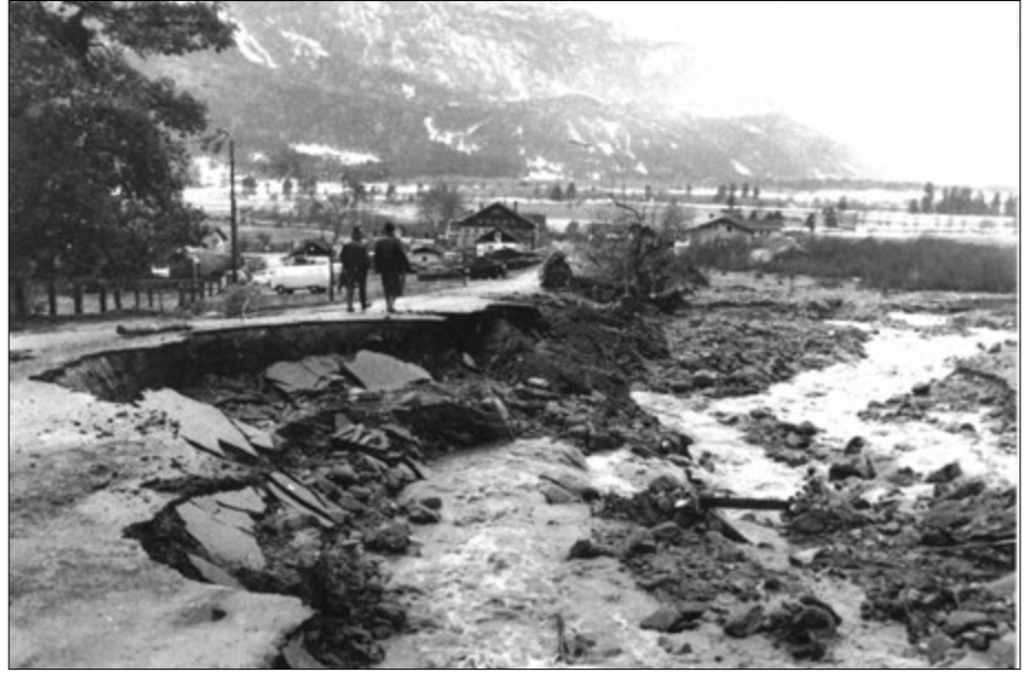
Hochwasser November 1966: Korrosionsschäden an der Dorfauffahrtsstraße durch den Dölsacher Bach oberhalb Kreuzwirt.
