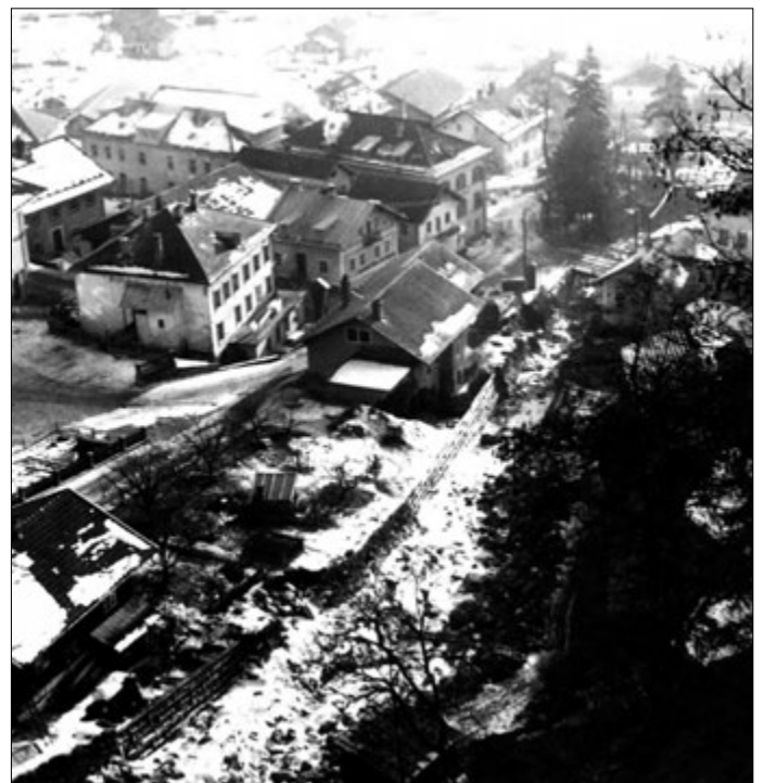
◀ Hochwasser November 1966: Erstsanierung im Ortskern.
