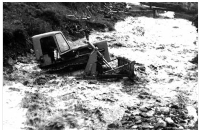
Hochwasser August 1966: oberhalb Sattlerbrücke. Foto: Dr. Franz Plössnig
