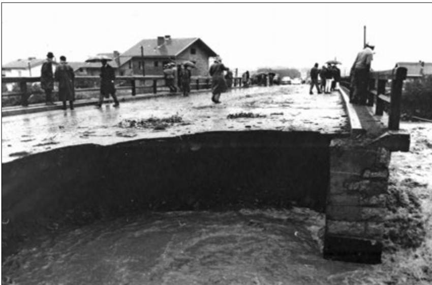
Hochwasser 1965: Der Debantbach umgeht das linksufrige Debantbachrückenwiderlager der Großglockner Bundesstraße.
