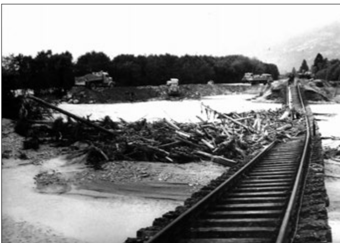
Hochwasser November 1966: Instandsetzungsarbeiten am Draudammbruch oberhalb der Lavanter Brücke. Foto: Dr. Franz Plössnig
