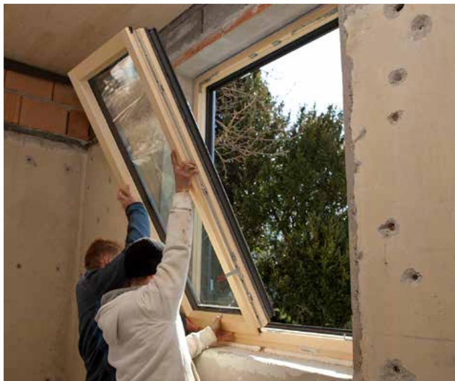
Der Fenstertausch wird idealerweise gemeinsam mit der Fassadendämmung durchgeführt – dadurch können die Anschlüsse optimal und wärmebrückenfrei ausgeführt werden. Fotorechte: © Energieagentur Tirol, e5-Gemeinde Dölsach
