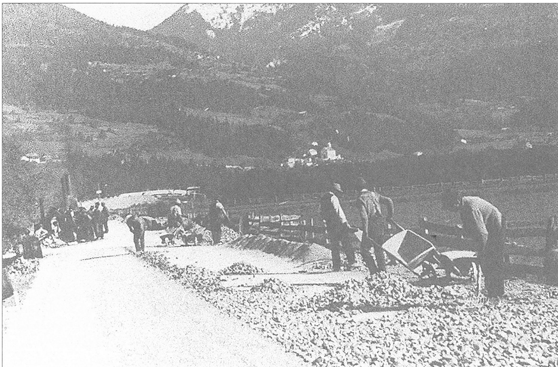
Bau der Bundesstraße 100, Abschnitt südlich Debant, Oktober 1933.
