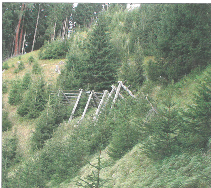
Projekt Rabenwand-Debanttal – der Jungwald kann bereits die Funktion der Lawinengalerie übernehmen.
