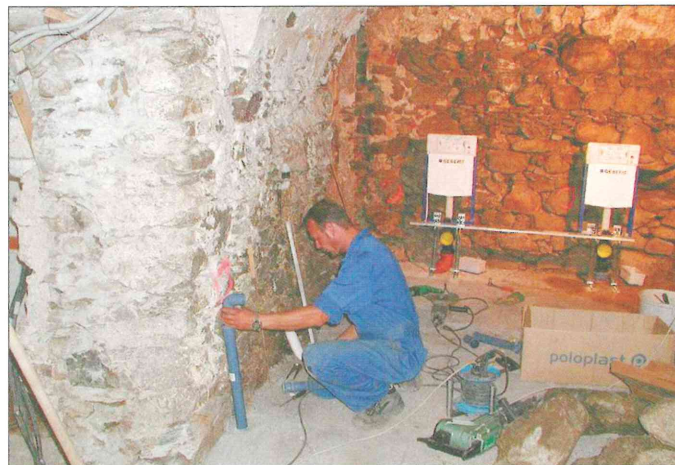
Der Gemeindearbeiter Hansjörg Resinger bei der Installation der Wasser- und Abwasserleitungen.
