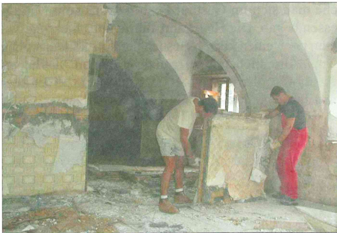
Christian Lukasser und Mario Egger beim Abtragen der Zwischenwände.
