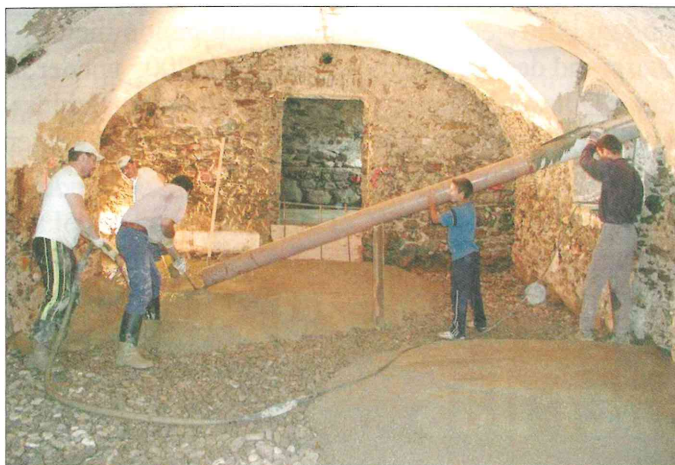
Unter tatkräftiger Mitwirkung der Maurer Georg Dorer und Erich Halbfürter konnte endlich wieder ein ebener Betonboden errichtet werden
