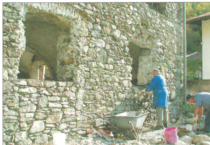
„Mauermeister“ Gottfried Schneider und „Straßenmeister“ Josef Klockner beim Wiederherstellen der Außenfassade.
