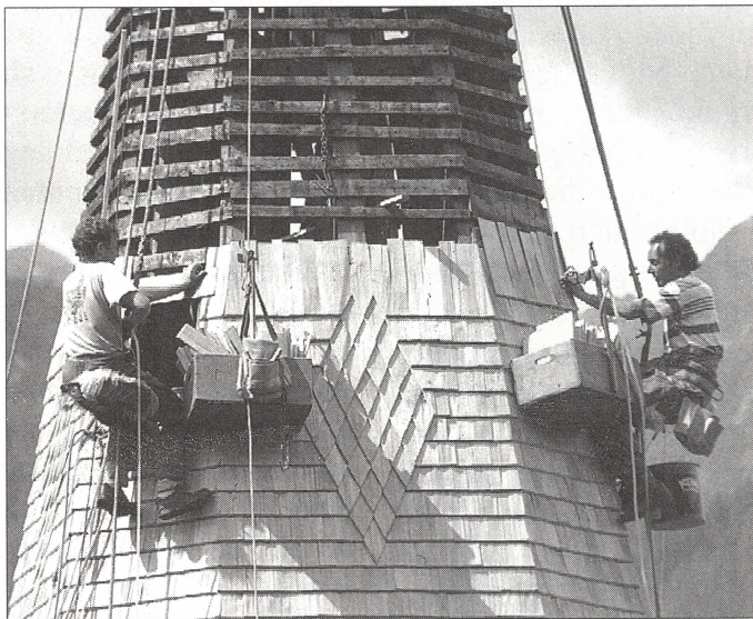
Hans Pondorfer und Mitarbeiter bei der Schindelneueindeckung.
