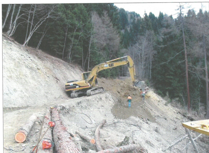
Sanierung einer 190 m langen Wegabrutschung mittels einer Lärchenholz Krainerwand.
