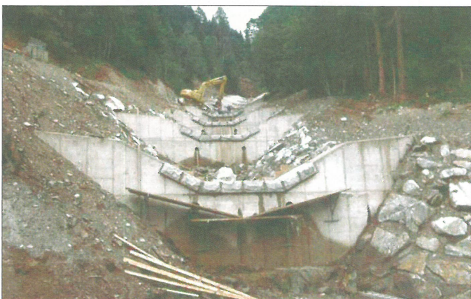
13 Betonsperren verhindern das „Eingraben“ des Gödnerbaches.
