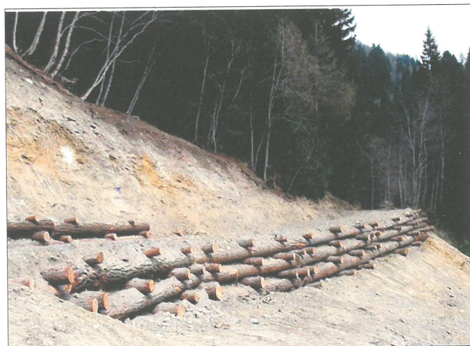
Sanierung einer 190 m langen Wegabrutschung mittels einer Lärchenholz Krainerwand.
