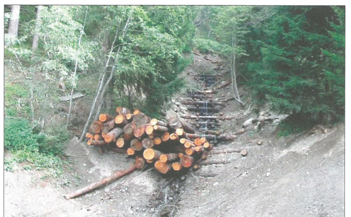
Der Gottschützgraben, ein Nebengraben des Gödnerbaches wurde mit 60 Sperren und 430 fm Lärchenholz stabilisiert.
