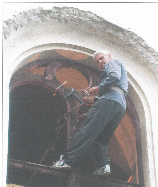
Siegmund Lindsberger am südlichen Westfassadenfenster bei der Reparatur des Fensterrahmens (25. Juni 2002).
