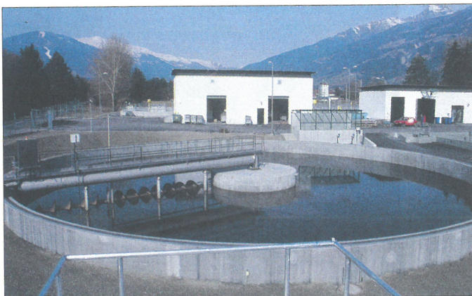
2.830 m 3 Inhalt und 30 m Durchmesser sind die Dimensionen des Nachklärbeckens.
