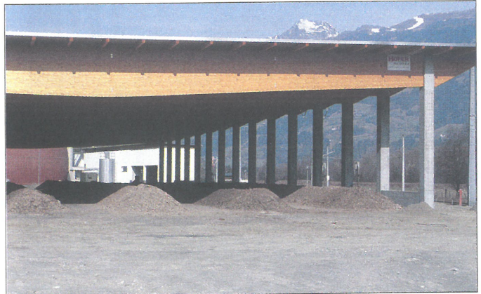
In der Kompostieranlage werden jährlich 2.000 bis 3.000 m 3 Klärschlamm zu hochwertigem Kompost verarbeitet. Fotos: DI Franz Mair
