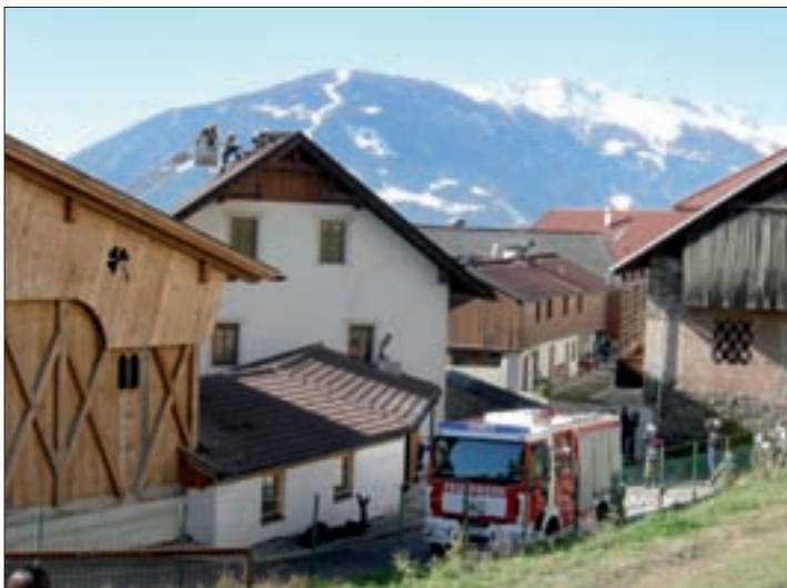
Dachstuhlbrand beim Messnerbauer im sogenannten Sauzipf.
