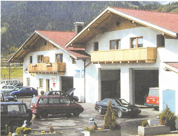
Das Betriebsgebäude wurde kürzlich mit dem Werkstättenzubau (re.) vergrößert
