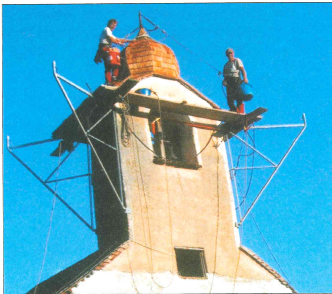
Reinhard Greil – Turm gedeckt am 4. September 2004 (oben) sowie Vordach fertig am 27. November 2004 (rechts).
