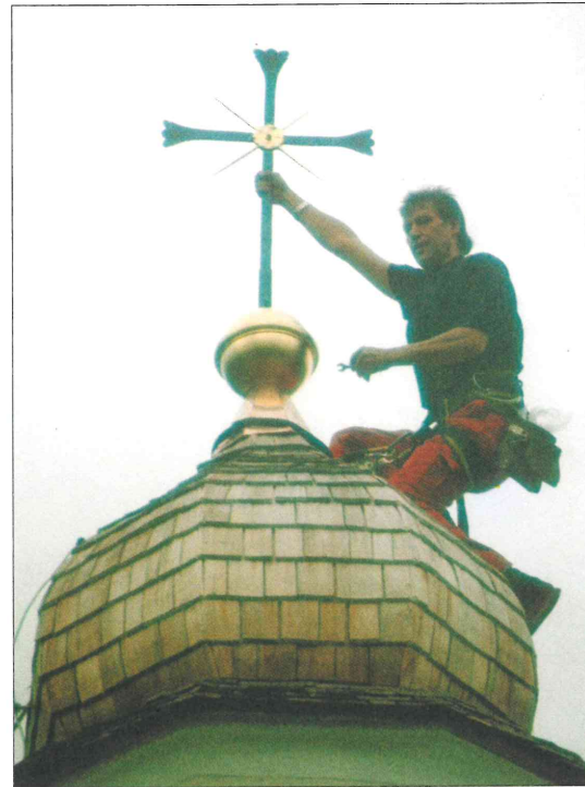
Die neuvergoldete Kugel und das restaurierte Turmkreuz wurden von Reinhard Greil auf den Turmhelm aufgesetzt (30. Juni 2005).
