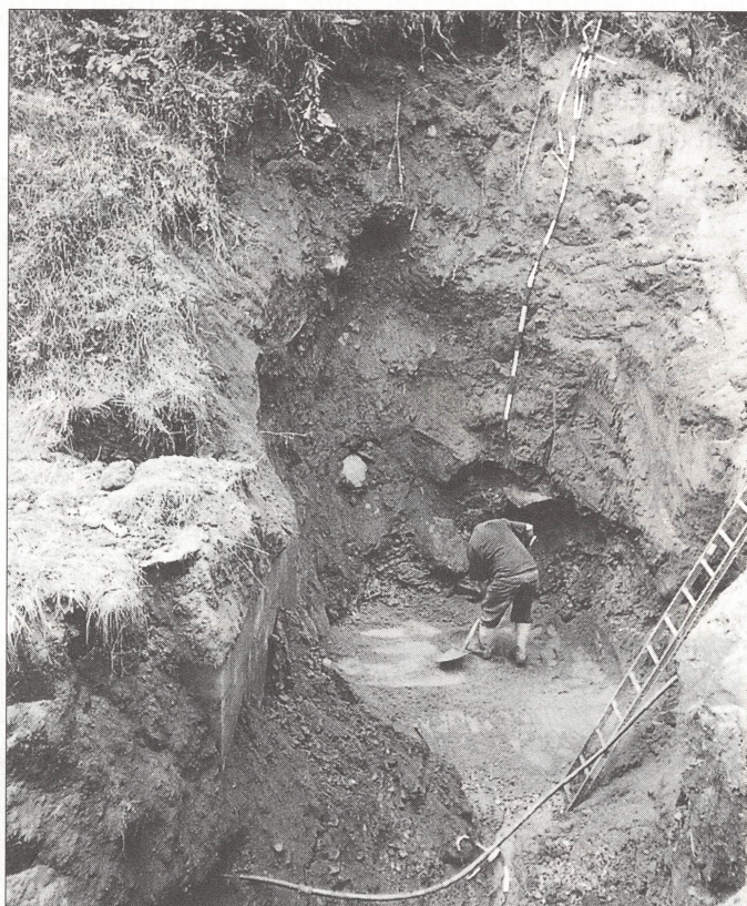
▲ Einbringung der Betonabdeckung bei der unteren Harbatquelle. Foto: Gemeinde Dölsach
