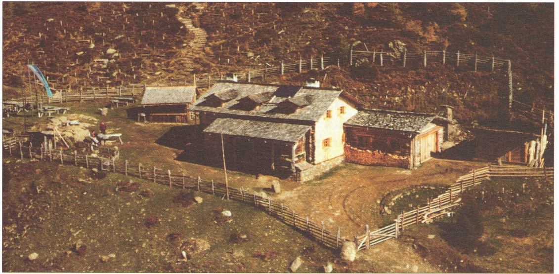
Das Anna-Schutzhaus nach der Renovierung
