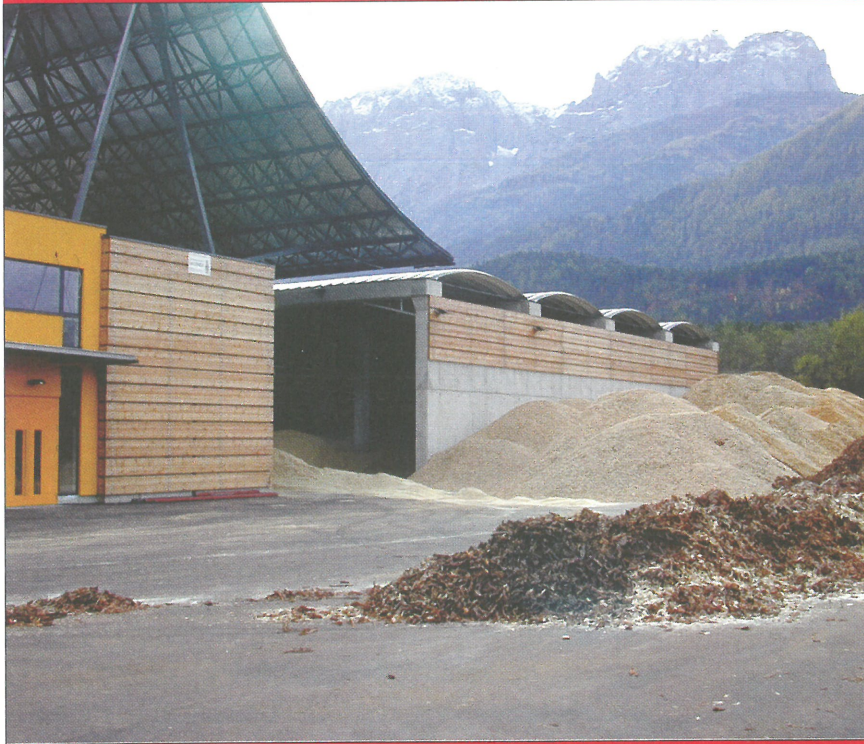
Stadtwärme Lienz mit Rinden- und Hackschnitzelanlage
