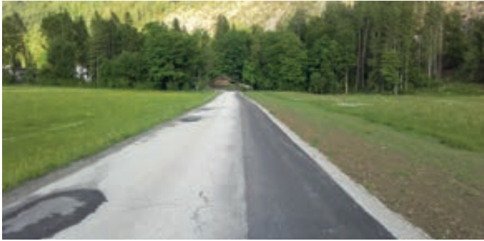
Die Fertigstellung des Kanalnetzes erfolgte vor kurzem.
