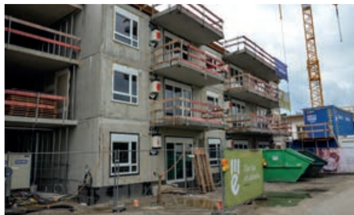
Die Arbeiten am dreigeschossigen Bau des neuen Sozialzentrums schreiten zügig voran.
