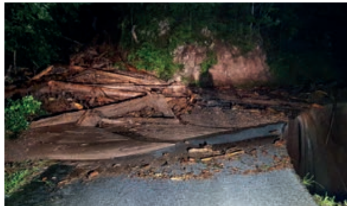
Schwere Schäden nach den heftigen Regenfällen.
