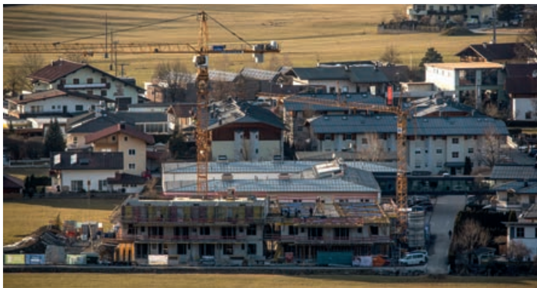
Die Fertigstellung des Gebäudes soll im Herbst 2022 erfolgen.
