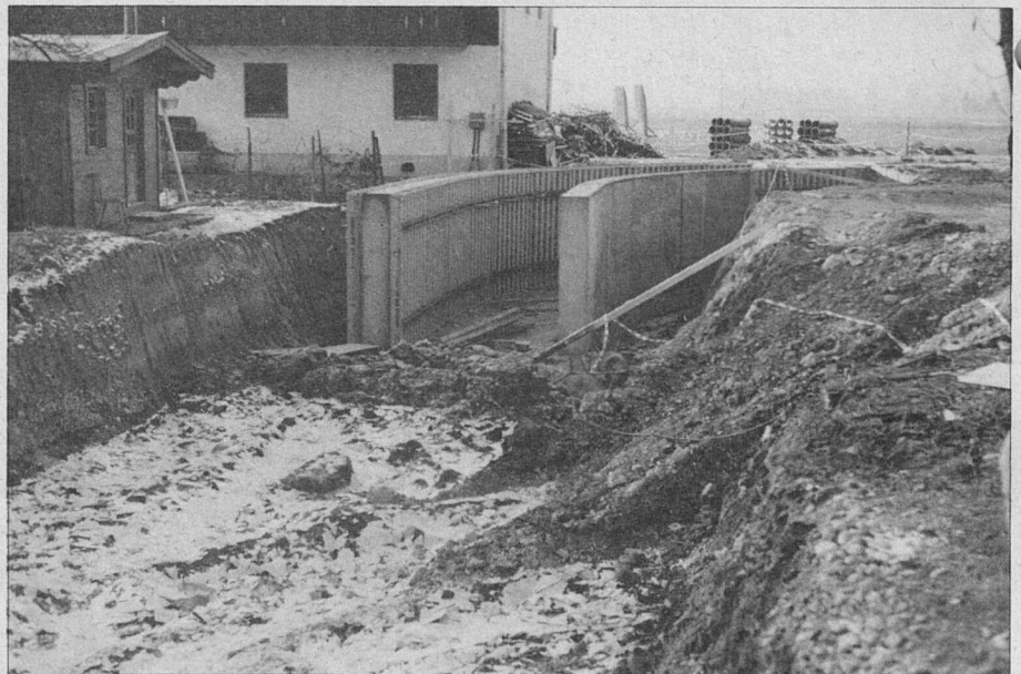
Ausbau des Heubaches im Bereich Saliterer/Metzger
