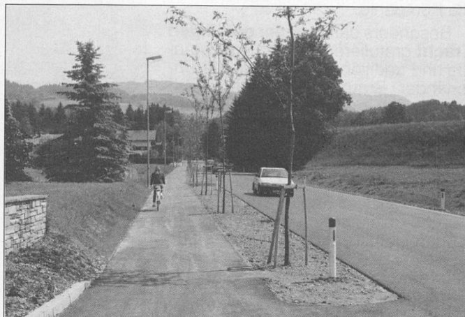
Die neu ausgebaute Bundesstraße mit dem Fuß- u. Radweg
