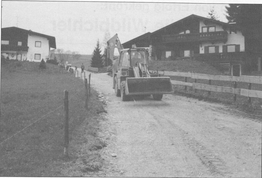
Straßenausbau Weiderost-Cafe Zacherl
