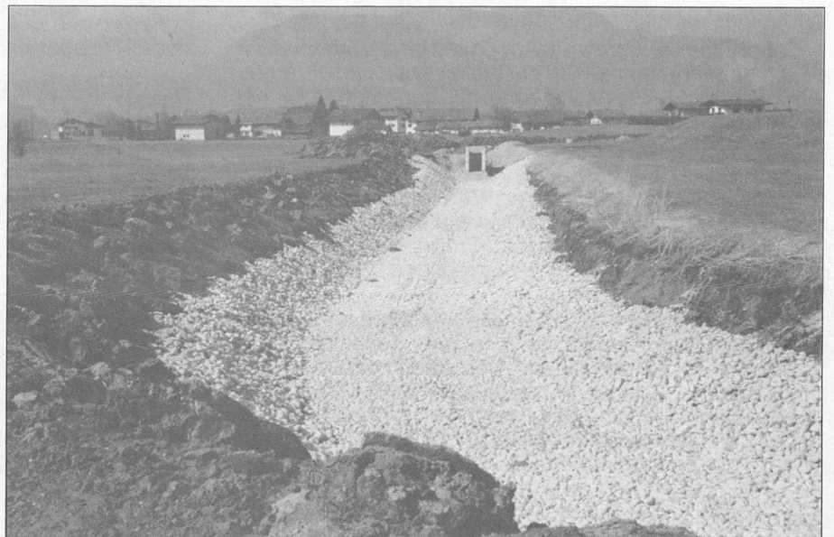
Oberflächenentwässerung für Oberndorf planmäßig fertiggestellt: Rückhaltebecken
