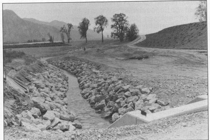
Der Begleitgraben ist auf österr. Seite weitgehend fertiggestellt und führt bereits Wasser
