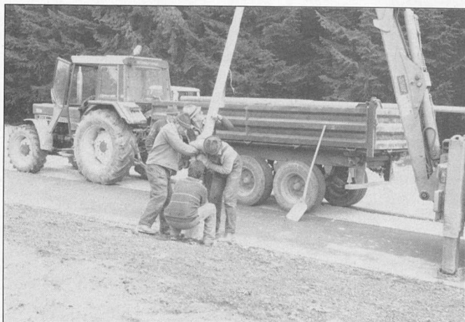
Bauhofarbeiter beim Aufstellen der Straßenbeleuchtung
