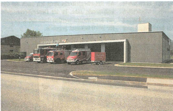
Das neue Feuerwehrgebäude in Ebbs
