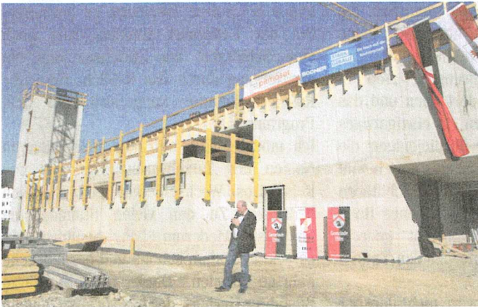
Im Frühjahr erfolgte die Firstfeier beim Feuerwehrhaus
