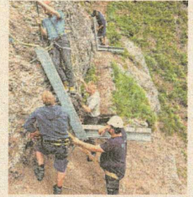
Stahlkonsolen für die Hangbrücke werden eingerichtet.
