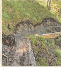
Hier wird der Weg in den Hang verlegt.
