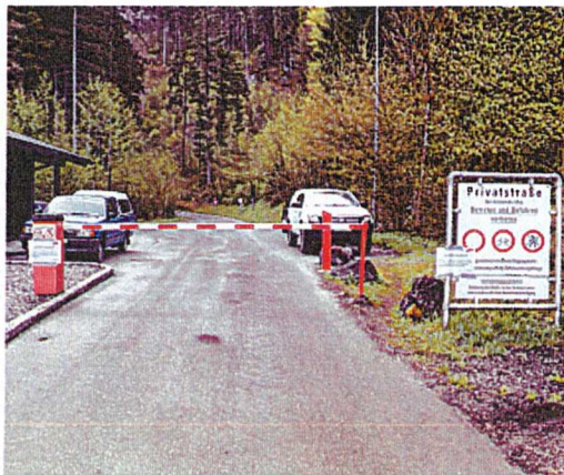
An der Einfahrt zum Kaisertaltunnel werden Autofahrer darauf hingewiesen, dass derzeit auch Fußgänger im Tunnel unterwegs sein können.
