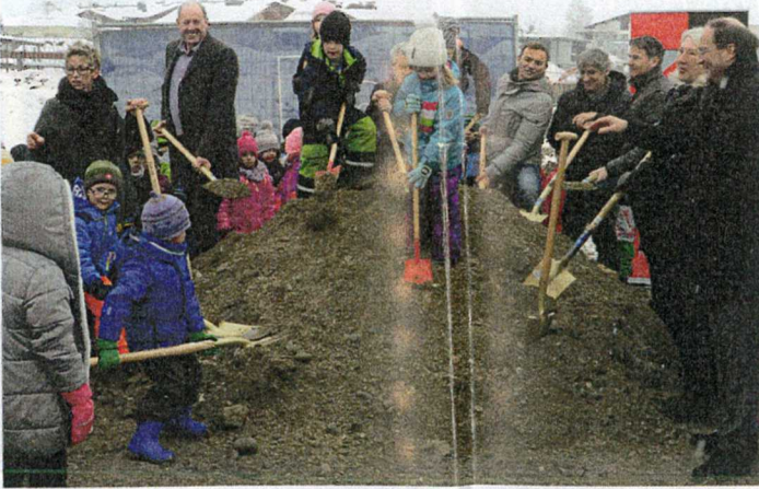
Auch die Kleinen waren eifrig beim Neubau des Kindergartens dabei
