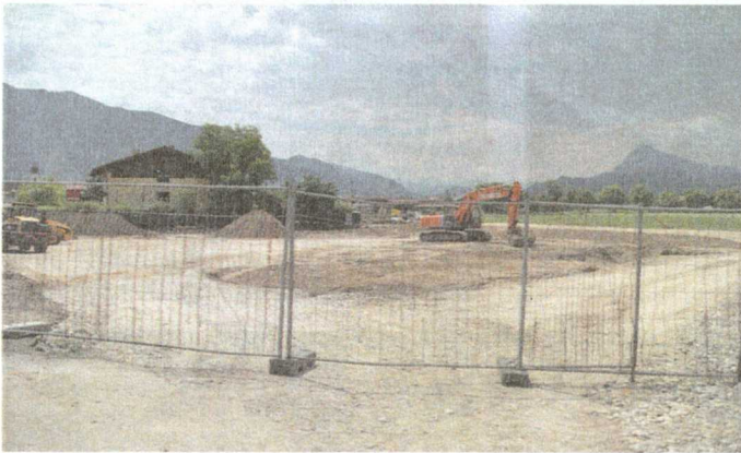
Direkt an der Straße nach Niederndorf, nach M-Preis und dem Blumengeschäft, wird das neue Feuerwehrhaus gebaut
