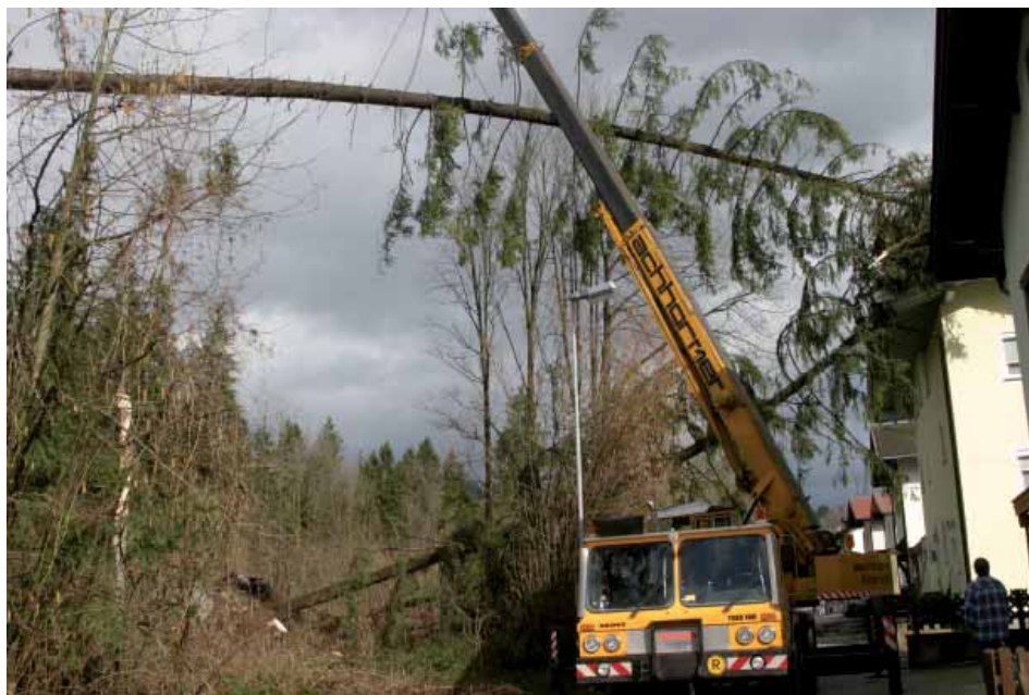
Ein Kran hebt einen Baum, der auf ein Wohnhaus in Oberweidach gestürzt war, weg.
