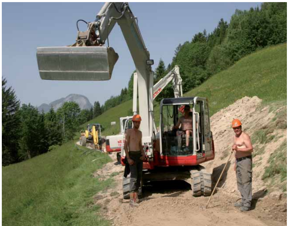
Die Kanalbaustelle Kaisertal zwischen Hofing und Pfandl.
