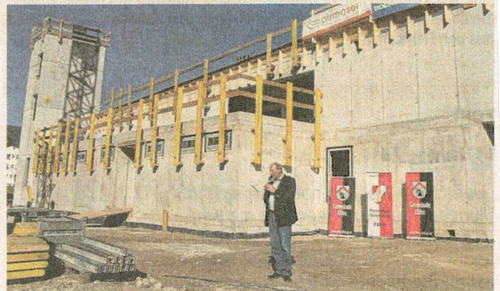
BM Sepp Ritzer vor dem Gerätehaus-Rohbau.
