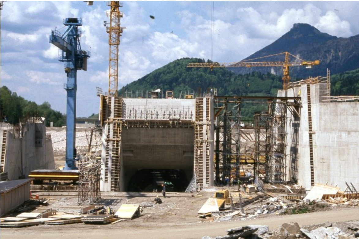
Baustelle Wehranlage, Foto Georg Anker
