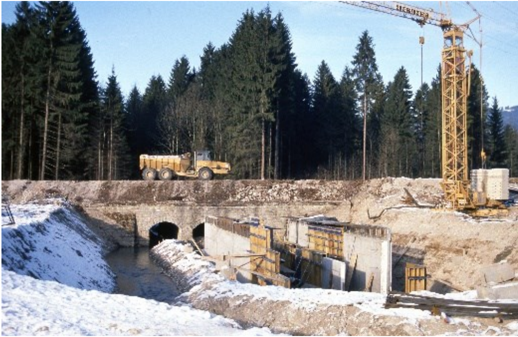
Altes und neues „Millionenloch“: Flussunterführung der Ebbse unter den Jenbach, Foto Georg Anker
