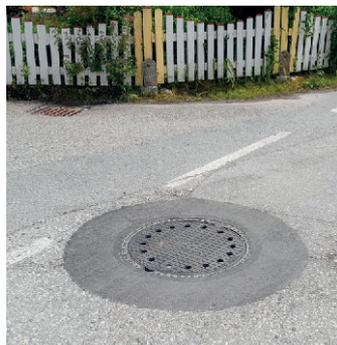
Mehrere Deckel, welche abgesunken waren, wurden gegen neue Selflevel-Deckel ausgetauscht. Hierfür muss der Asphalt rund um den Deckel miterneuert werden.
