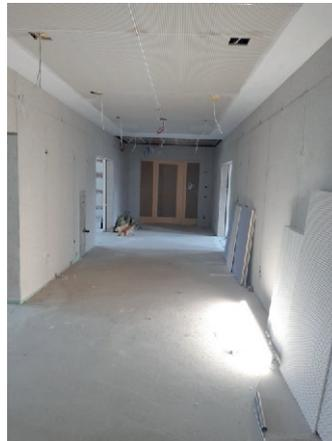
Die Decke im Flur im EG ist in Arbeit, die Leuchten usw. müssen noch installiert werden. Der Terrazzo wird hier bald verlegt.
