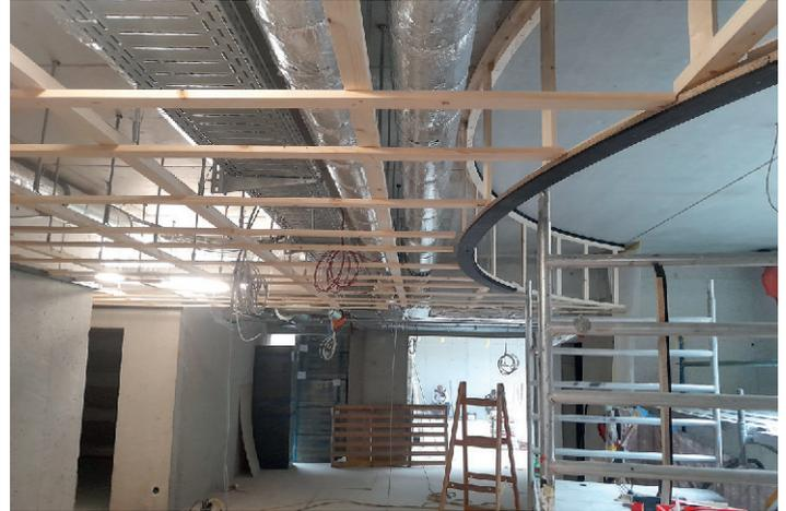
Im 2. Obergeschoß wird derzeit an der Unterkonstruktion für die Holzdecken gearbeitet, ...
