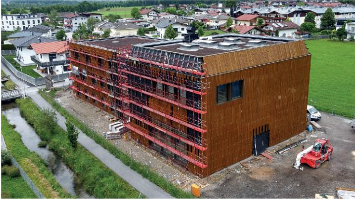
Am Bild gut erkennbar die östliche, fast fertiggestellte Fassade. Im Süden ist noch das Gerüst vorhanden, einzelne Elemente der Keramikfassade wurden hier bereits befestigt (Fotonachweis: Michael Jahns, AEP).
