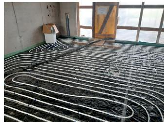
In den Fluren und Sälen wurde eine Fußbodenheizung eingebaut.
