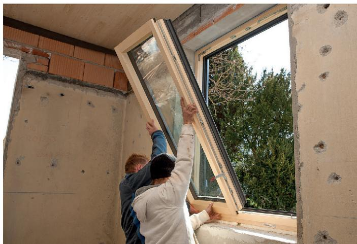
Der Fenstertausch wird idealerweise gemeinsam mit der Fassadendämmung durchgeführt - dadurch können die Anschlüsse optimal und wärmebrückenfrei ausgeführt werden (Fotonachweis: Energieagentur Tirol).
