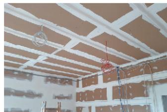
Anschließend wurde die Decke mit Gipskartonplatten verschlossen. Die Anteile der glatten bzw. gelochten Flächen wurde durch den Akustiker festgelegt.
