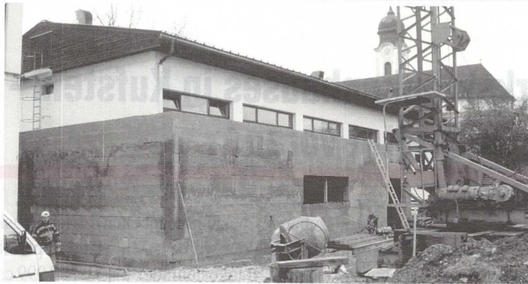
Neuer Geräteraum im Rohbau
