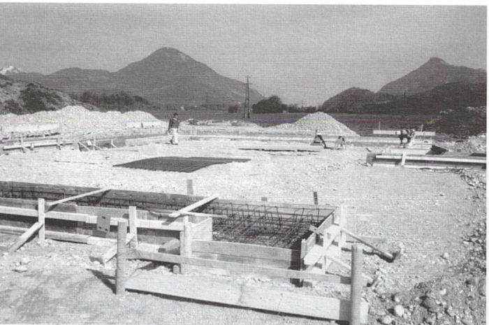
Fundierung des Schwimmbeckes (April).
