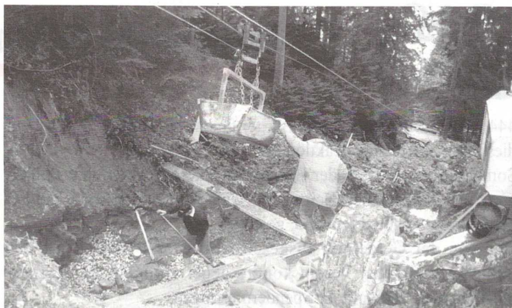
Neufassung der Quellstube unter schwierigen Bedingungen
