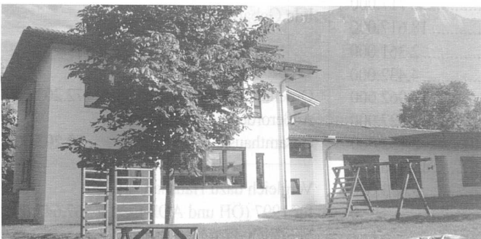
Kindergartenbau: 2 neue Gruppenräume und weitere Nebenräume im Anbau (1995)
