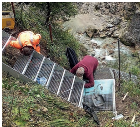
Die Bauhofmitarbeiter beim Bau der Treppenkonstruktion aus Stahl.
