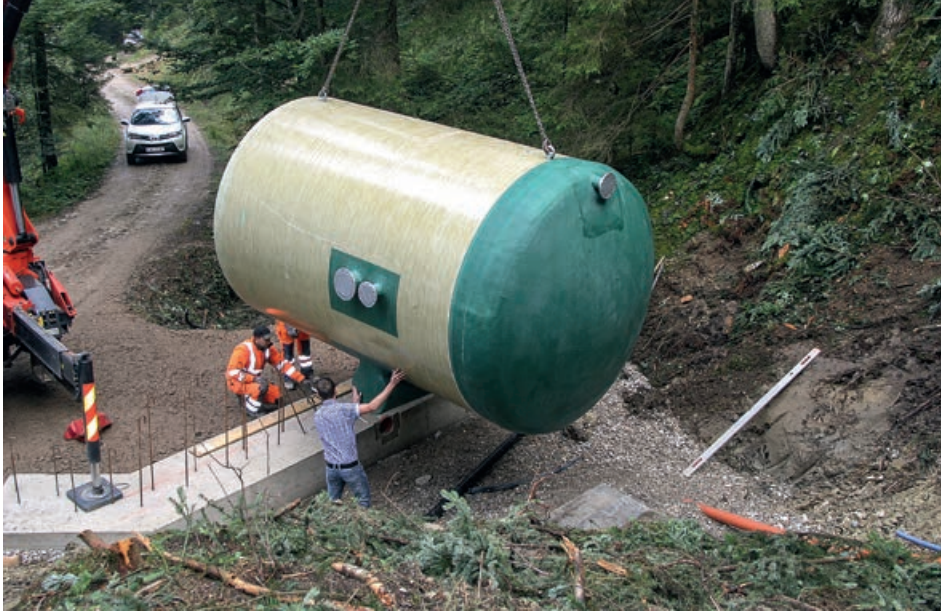
Die Bauhofmitarbeiter beim Versetzen der Brunnenstube.
