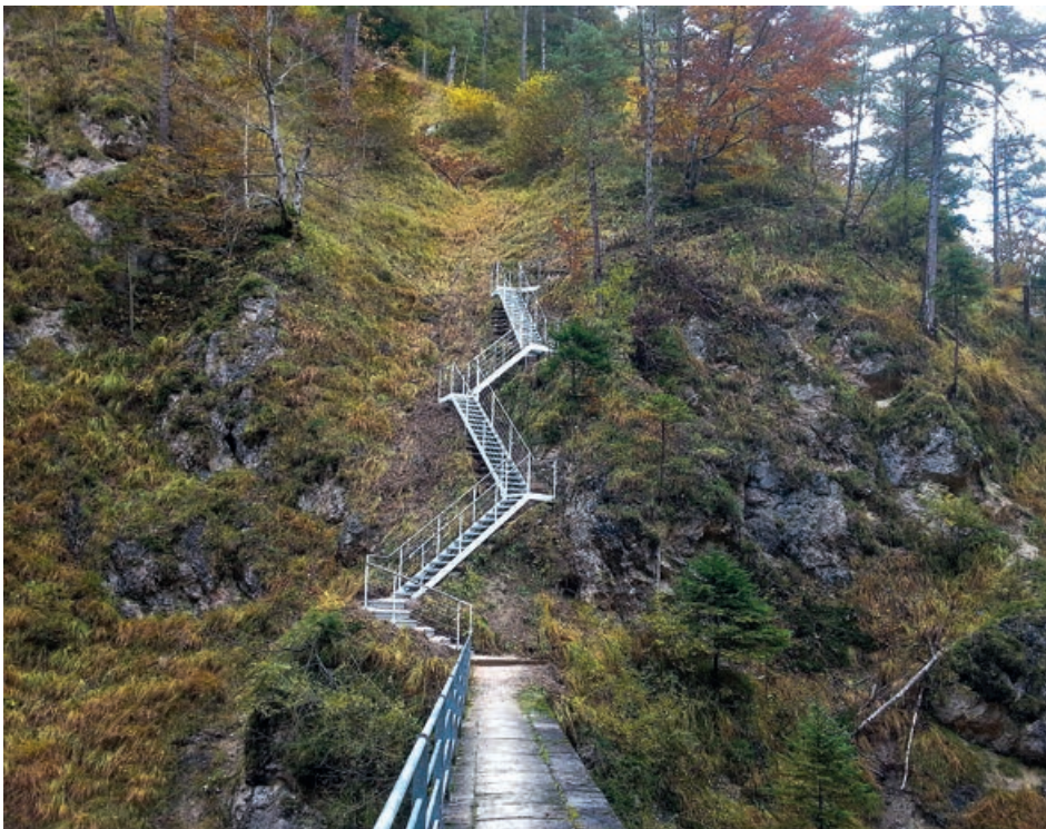
Die fertige Treppenkonstruktion zur Tischoferhöhle.
