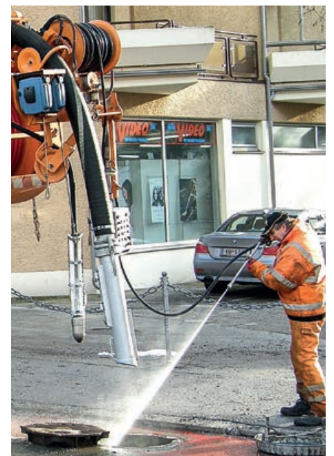
Die Kanalfirma bei der Spülung des Rohrnetzes.
