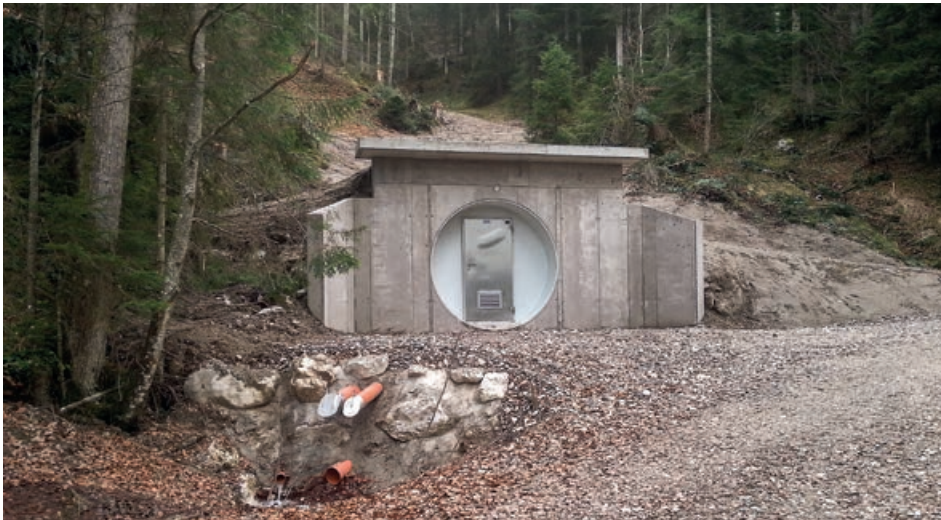
Die neu errichtete Brunnenstube Kölnberg.
