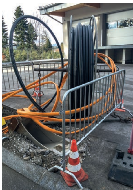
Bereits über 32.000 Meter Lichtwellenleiter-Kabel wurden in der Region Untere Schranne - Kaiserwinkl verlegt.
