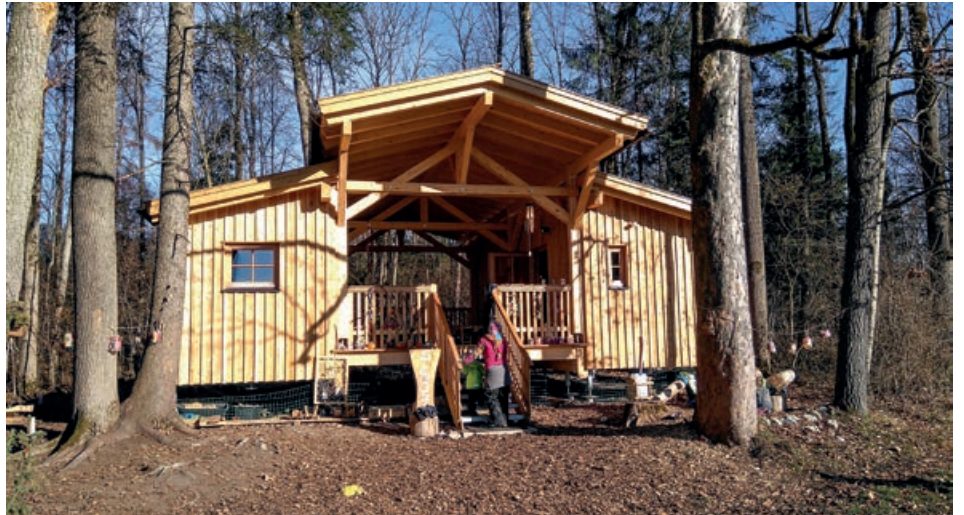
Das beheizte Waldhaus der Waldkinderkrippe.
