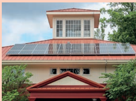
Formulare für den Antrag auf Förderung der Solar- bzw. Photovoltaikanlage können auf der Homepage der Gemeinde Ebbs unter www.ebbs.tirol.gv.at heruntergeladen werden.
