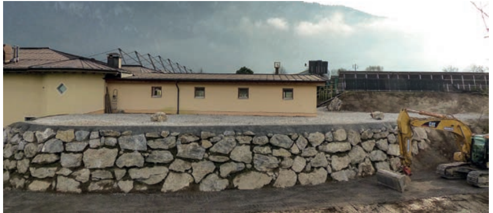
An der Nordseite der Freizeitparkanlage wurde eine Natursteinmauer errichtet. In den Sommermonaten kann diese nun als zusätzliche Liegefläche von den Saunagästen benützt werden.
