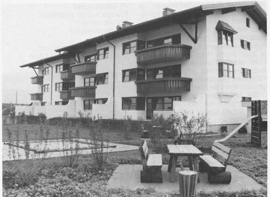
Gelungene Wohnanlage kurz vor Fertigstellung
