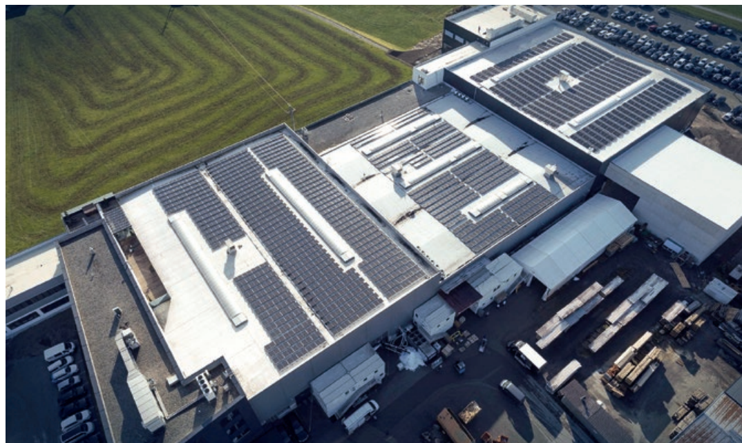
Auf dem Dach der Montagehallen sorgen Photovoltaik-Module für die Stromversorgung.
