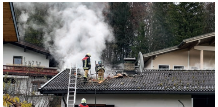
Teile der Dachhaut mussten entfernt werden.
