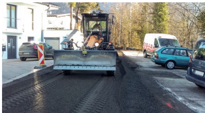
Vor kurzem konnten die Arbeiten mit dem Gräber starten.
