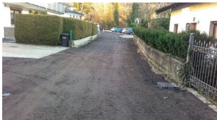
Im Zuge der Straßensanierung wurden neue Einlaufschächte gesetzt, um die Straßentwässerung zu verbessern.
