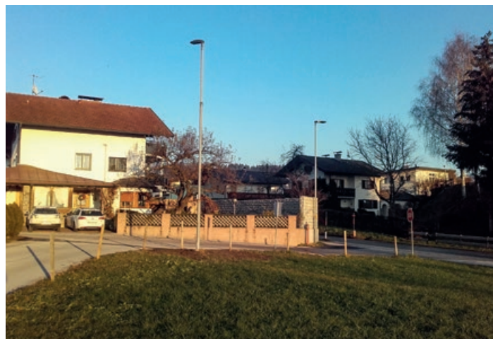
In Oberweidach wurden die Lampenköpfe auf energiesparende LED-Leuchten umgerüstet.
