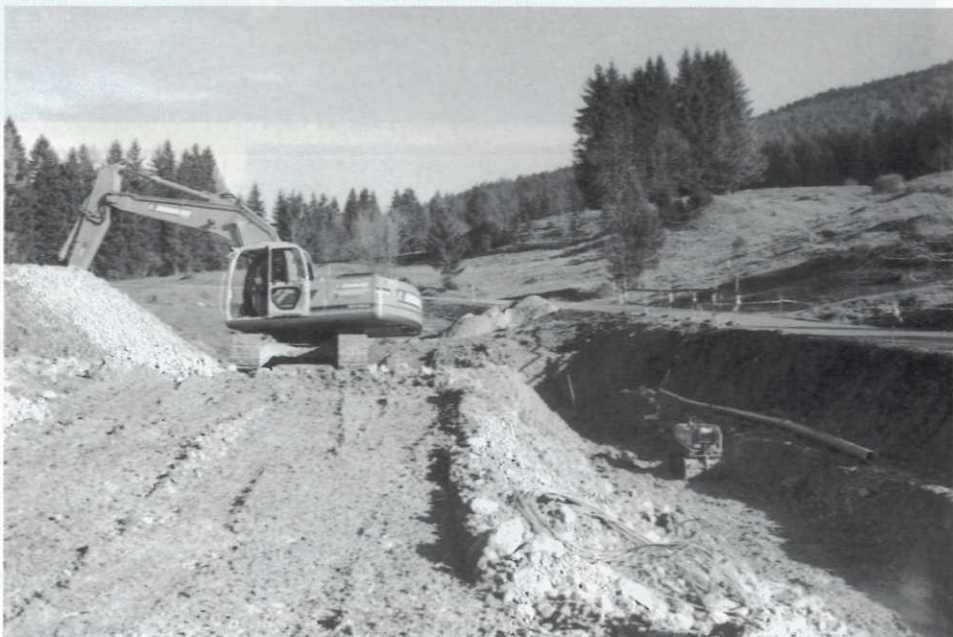
Erdarbeiten für die neue Leitungstrasse am Feldberg
