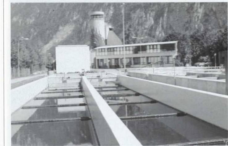
Die neu renovierten Nachklärbecken und das erweiterte Betriebsgebäude.
