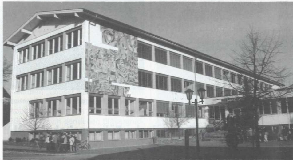
Die Hauptschule zeigt sich nach der Sanierung im „neuen Kleid“.
