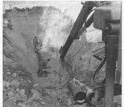
*Unter dem Jenbach wird im Bereich Oberweidach eine Wasserleitungsverbindung zu Niederndorf verlegt.*
