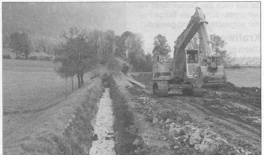
*Mit dem Ausbau des Zacherlbaches, der bei starken Regenfällen gewaltigen Wassermassen führt, sollen Hochwasserschäden hintangehalten werden.*
