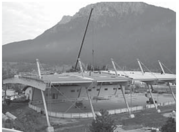
Das Dach wird mit 2lagigen Bitumendachbahnen (Dachfläche ca. 2.950 m 2 ) eingedeckt. Es erhält ein Tageslicht-Dachlichtband über die gesamte Dachlänge mit Lüftungsflügeln und zusätzlichen Lichtkuppeln.
