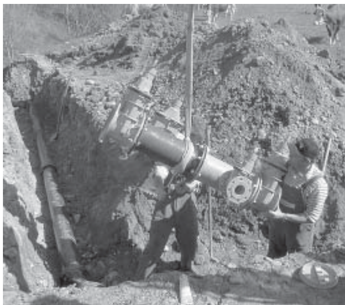
Die Mitarbeiter des Bauhofes bei der Leitungsverlegung in Richtung Oberndorf.
