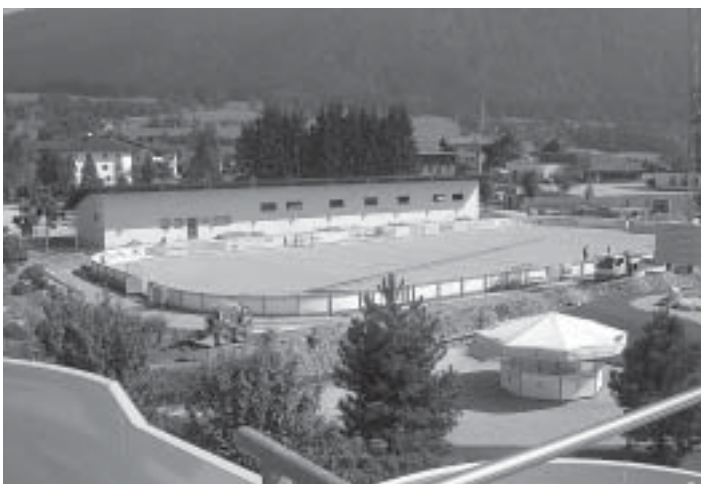
Der Eislaufplatz der Funarena Ebbs bei Beginn der Bauarbeiten für die Überdachung.
