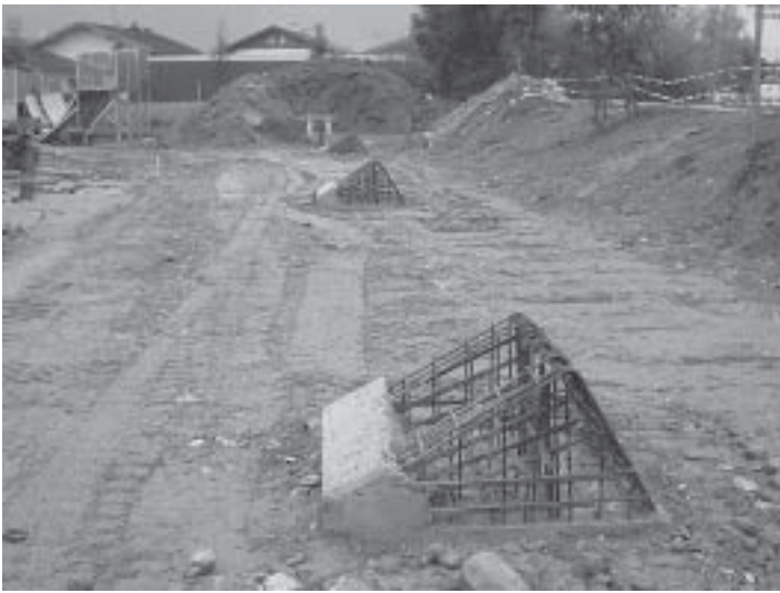
Zuerst werden die Stahlbeton-Einzelfundamente, auf denen später die Stahlstützen für die Dachkonstruktion aufgesetzt werden, errichtet.
