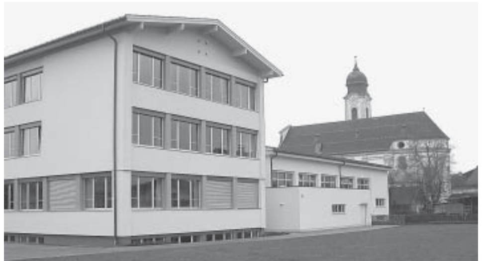
Auch die Hauptschule und Mehrzweckhalle wurden saniert.
