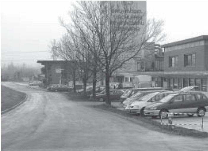
Neue Erschließungsstraße Gewerbegebiet Kleinfeld.
