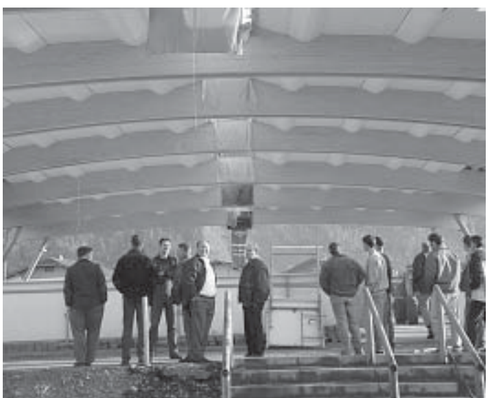
Die Firstgleiche konnte bereits nach nur 7 Wochen Bauzeit am 18. Oktober 2002 gefeiert werden. Im Bild die vom Eislaufplatz aus gesehene helle Akustikdecke mit den Lichtabsorbern und dem Lichtband.
