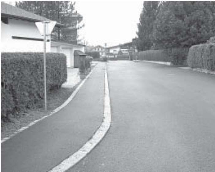
Sanierung der Millauerstraße mit Anlage eines Gehweges.
