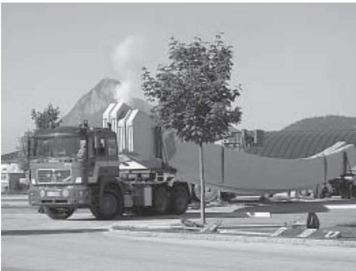
Die vorgefertigten Leimbinder (ca. 40 Meter lang) treffen auf dem Parkplatz des Hallo du ein.
