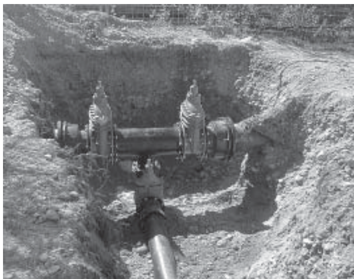
Die neue Leitung NW 200 zweigt in Kleinfeld von der Transportleitung NW 300 ab.
