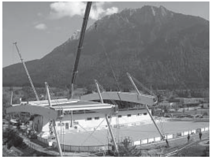
Der erste Teil der freitragenden, bogenförmigen "Holz-Brettschichtbinder-Konstruktion" steht.
