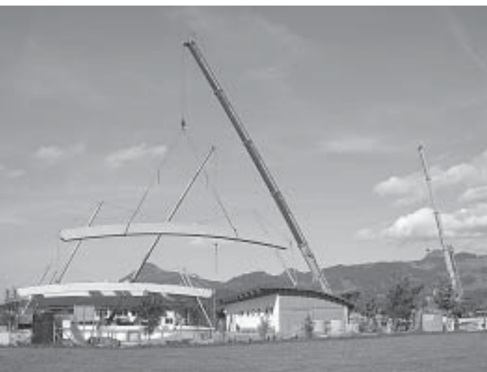
Diese werden mit einem 500-Tonnen-Spezialkran über das Gebäude der Ebbser Eisschützen auf den Eislaufplatz gehievt. Gut zu erkennen, die zuvor an die Leimbinderkonstruktion angebrachten Stützen, die als Schrägsäulen dienen und aus verzinkten und ausbetonierten Stahlpylonen bestehen.
