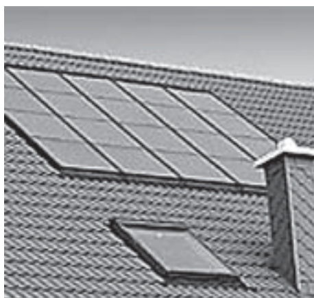
In der Dachhaut integrierte Solaranlagen stören auch das Ortsbild nicht.
