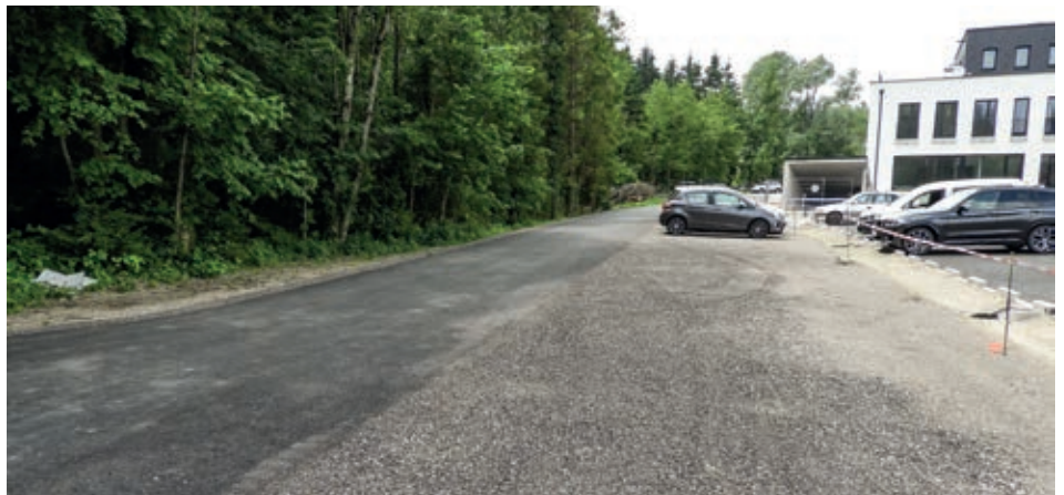
Am neu errichteten Parkplatz können bis zu 25 PKW abgestellt werden.
