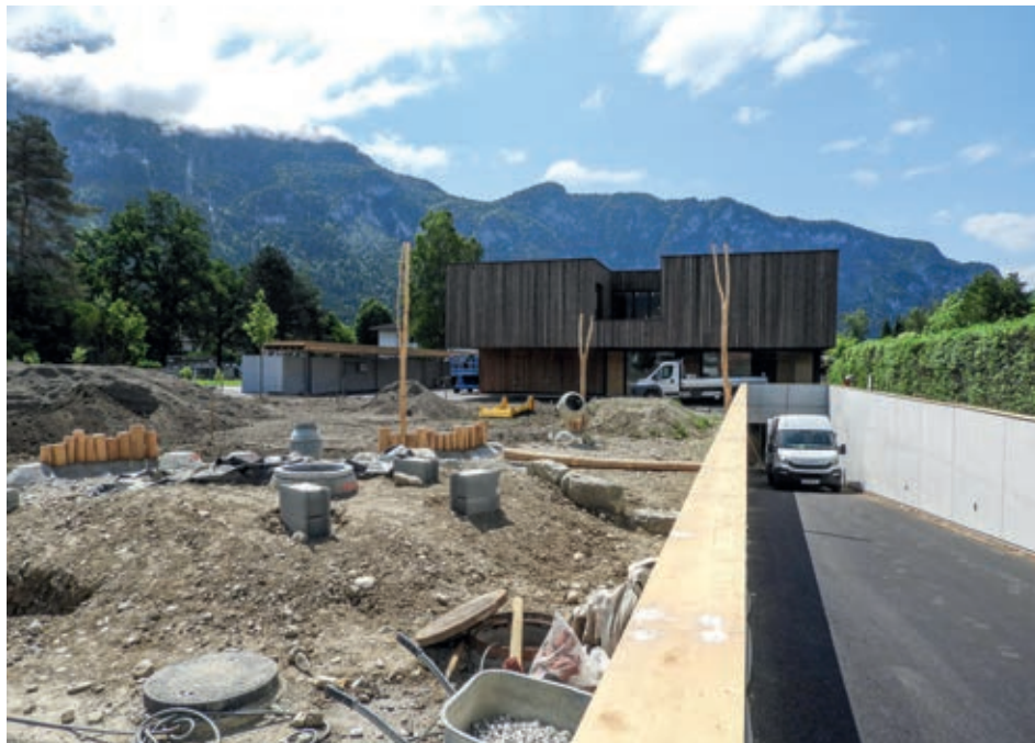
Die Tiefgaragenzufahrt in den neuen Kindergarten ist bereits asphaltiert. Mit der Errichtung des Erlebnisspielplatzes für den Kindergarten wurde gestartet.
