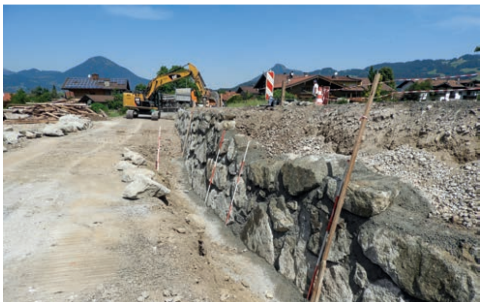
Die Arbeiten für die Verbreiterung der Kaiserbergstraße gehen zügig voran.
