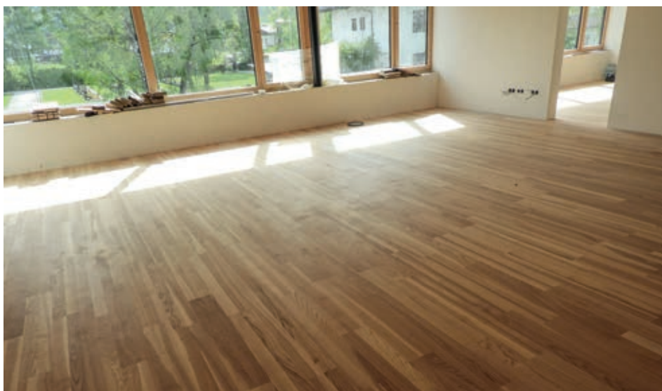
Vor kurzem wurden die Holzfußböden im neuen Kindergarten verlegt.
