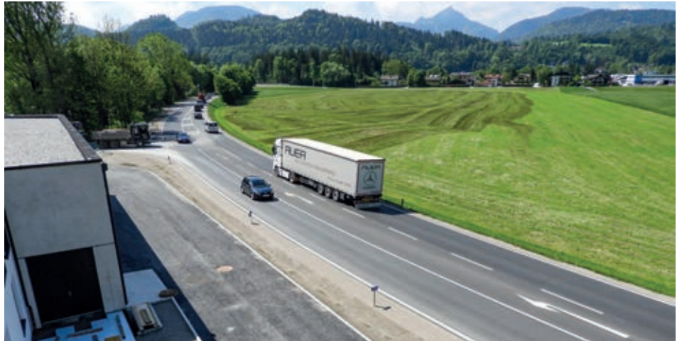
Blick auf die neue Abbiegespur bei der Kaiser Nordwand.
