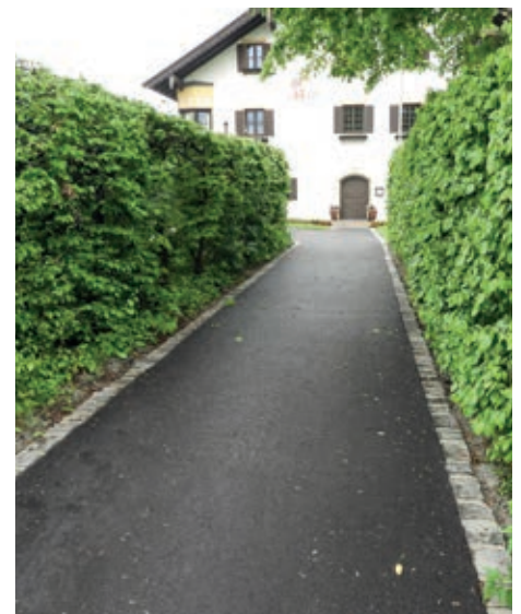
Der neue, breitere Asphaltbelag.
