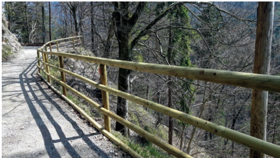
Das reparierte Geländer beim Kaiseraufstieg.
