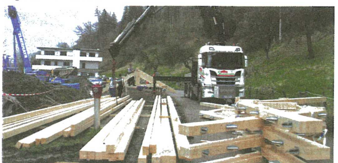
Neben der Straße haben die Zimmerer die vorgefertigten Teile zusammengebaut
