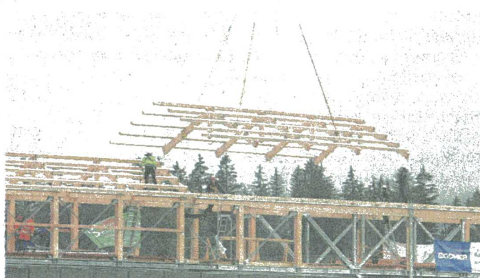
Mittels Kran wurde auch das Dach des neuen Innstegs eingehoben.
