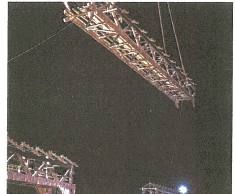
Innerhalb von drei Nächten wurde die Brücke in drei Teilen wieder eingehoben
