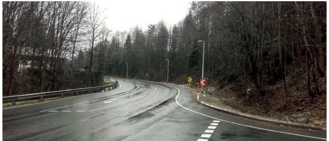
Die neue Straßenbeleuchtung in Schmidtal – Auffahrt Buchberg.
