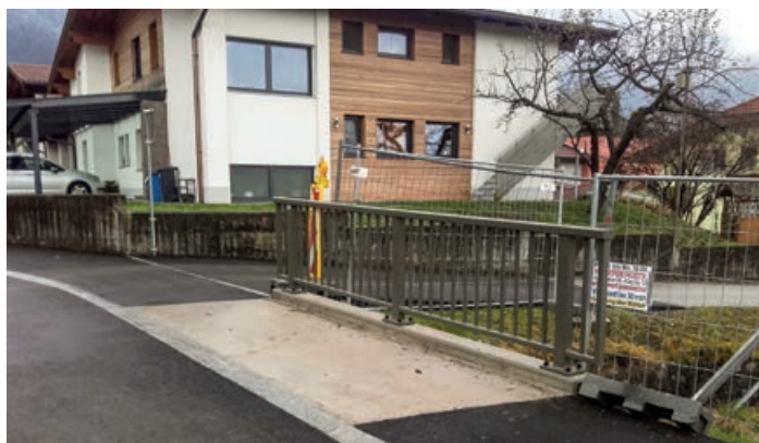
Das neue Geländer an der teilweise neuerrichteten Brücke bei der Kaiserbergstraße.
