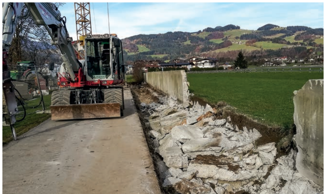
Abbruch der bestehenden ostseitigen Einfriedungsmauer.
