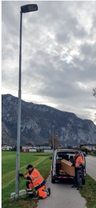
Unsere beiden Gemeindeelektriker bei der Installation der neuen LED-Leuchten.
