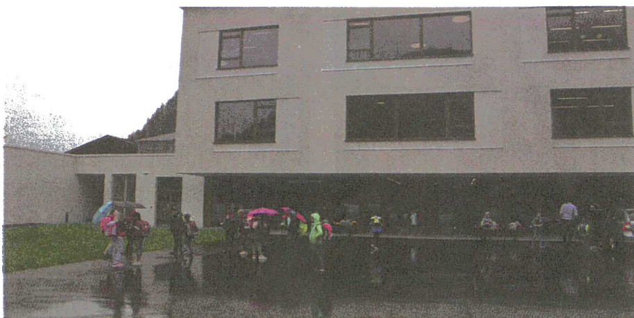
Im Jahr 2019 wurde in Walchsee das neue Volksschul-Gebäude eröffnet. Bei der Abwicklung von Planung, Ausschreibung, etc. hat man auf die erfahrenen Mitarbeiter der GemNova gezählt und das hat sich auch bewährt.
